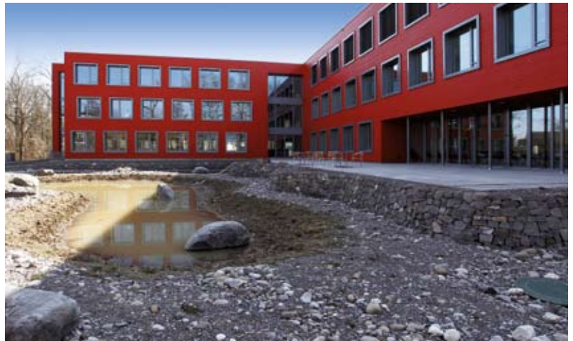
Le jardin encore dégarni se transformera en une petite oasis naturelle abritant étang et murs de pierres sèches.
